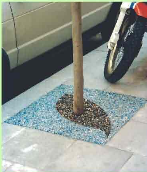
Alcorque drenante en vidrio reciclado I. Sanfeliu, arquitecto.
